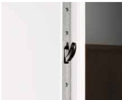
8. Mehrfachsicherheitsschloss mit Schwenkriegel
