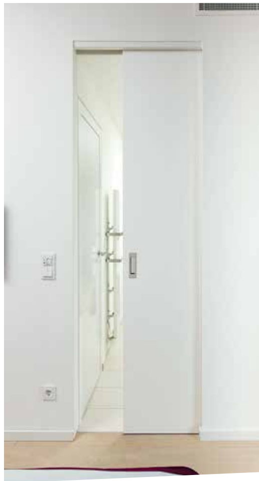
Porte camouflée coulissante, Vue de l'extérieur / Sliding pocket door, outside view
