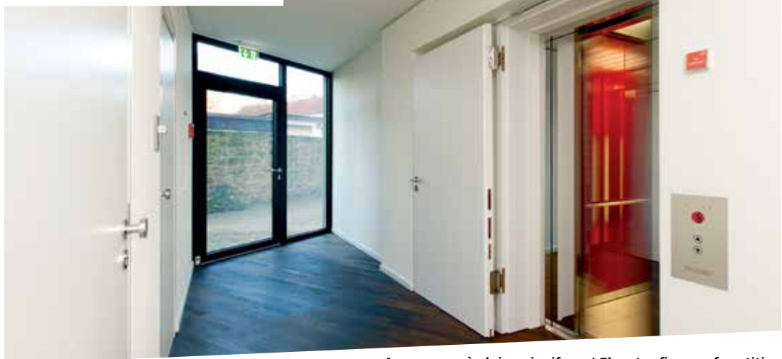
Ascenseur à cloison ignifuge / Elevator fireproof partition Dispositif de protection anti-incendie avec parafoudre (aimant de retenue) Fire protection element with arrester (holding magnet)
