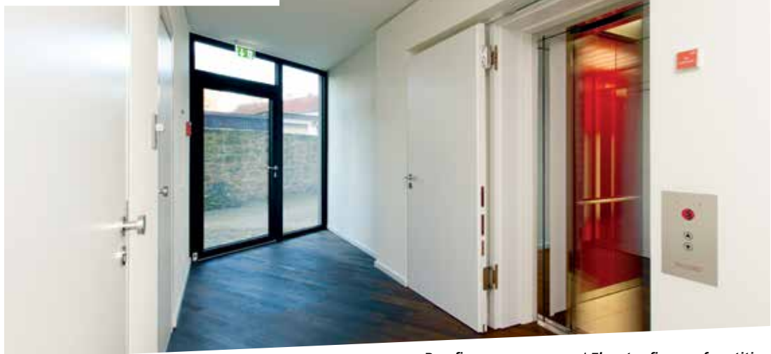
Parafiamme ascensore / Elevator fireproof partition Elemento protezione antincendio con bloccaggio (magnete di ritenuta) Fire protection element with arrester (holding magnet)
